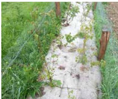
Ce grillage est à implanter autour du linéaire de paillage situé au niveau du passage d'eau. Il doit être maintenu par des piquets de châtaignier ou d'acacia de 1,50 m et d'un diamètre minimal de 10 cm (1 piquet tous les 2 à 3 m) avec deux cavaliers par piquet
