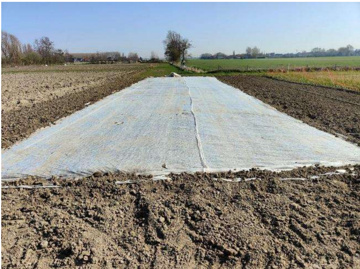
Photographie de la pose du P17 sur le site de Lorgies
