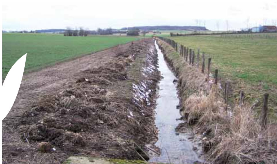
Curage d'un fossé
