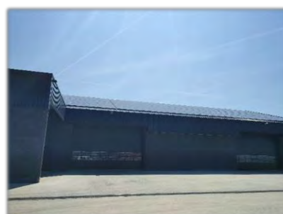
Aile droite du bâtiment pour le stockage des autres cultures (oignons, carottes...). On peut observer sur le toit, les panneaux photovoltaïques
