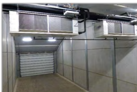
Evaporateurs dans la cellule de stockage
