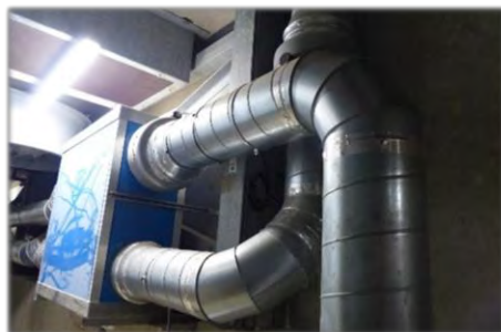
Extracteur à CO 2 et son tuyau au sol perforé à distance égale pour aspirer le CO 2
