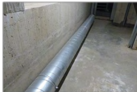
Extracteur à CO 2 et son tuyau au sol perforé à distance égale pour aspirer le CO 2
